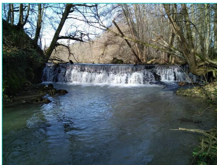
Photo du déversoir avant travaux
