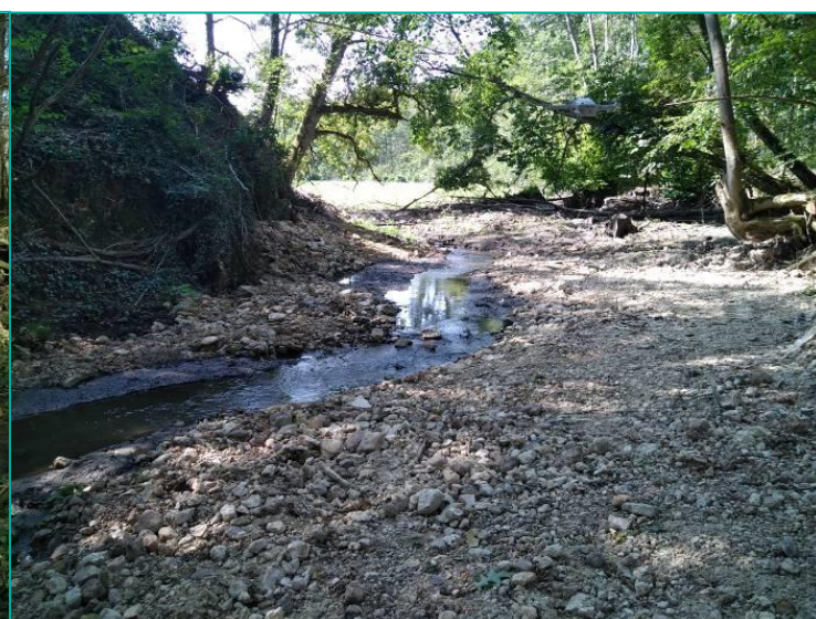
Photo après travaux à l'emplacement du déversoir
